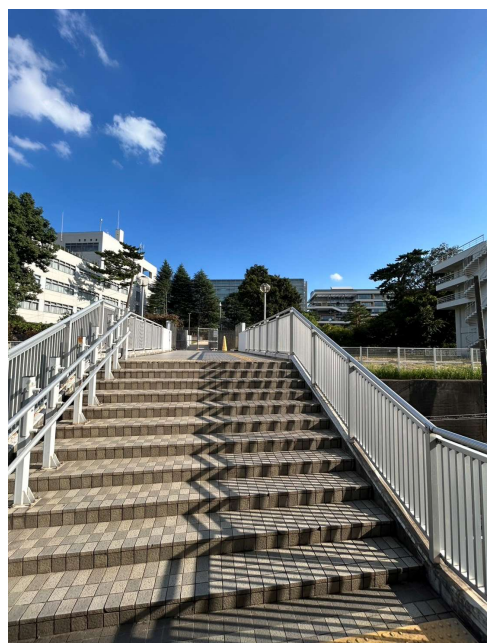
体育館への連絡橋
